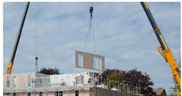
Dachaufbauten in Holzsystembauweise
